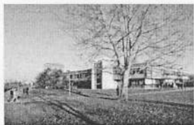
Auf der Freifläche links des ESB-Neubaues sollen zwei weitere Hochschul-Gebäude entstehen. Bild: Haas
